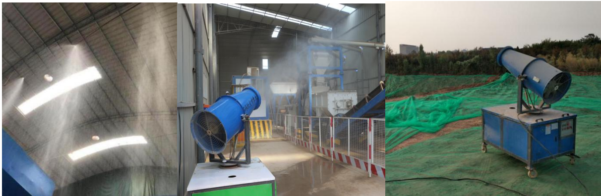
图 13 取土场、拌和厂生产区降尘措施
